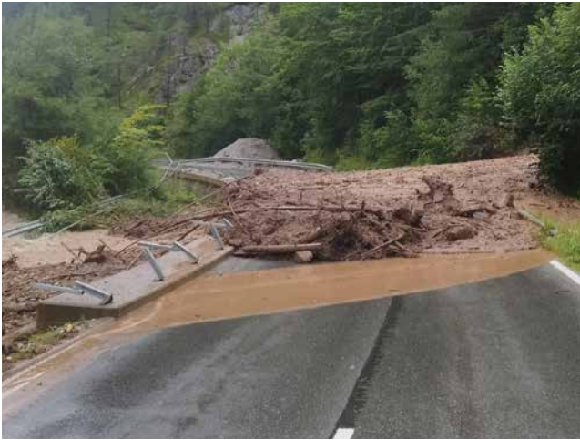
Murenabgang, Seebergbundesstraße in Vellach
